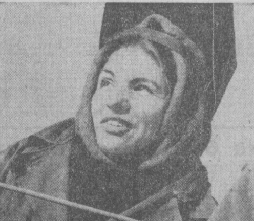
Хорошо работает на строительстве четвертой очереди Ташкентской ГРЭС сварщица Людмила Петрова. Она сармает арматуру каркаса под основную станцию, дневные нормы систематически перевыполняет.
