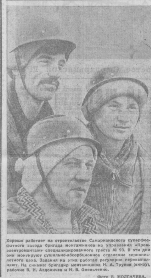
Хорошо работает на строительстве Самаркандского суперфосфатного завода бригада монтажников из управления «Промэлектромашины» специализированного треста № 93. В эти дни они монтируют сушильно-абсорбционное отделение сернокислотного цеха. Задания на этих работах регулярно перевыполняют. На снимке: бригадир монтажников Н. А. Трунов (внизу), рабочие В. И. Азодчиев и И. В. Омельченко.
