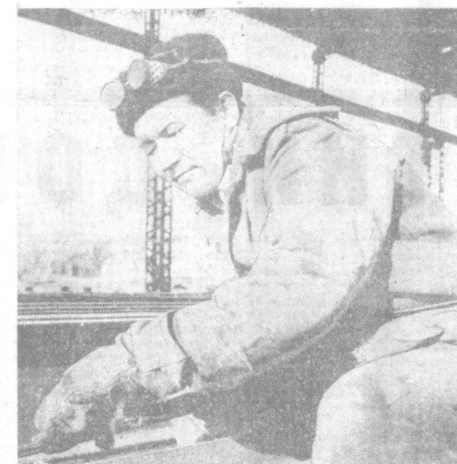
Коллектив Тахташского ремонтно-механического и строительного цеха работает из года в год с перевыполнением заданий. Он выпускает фундаменты и карнасы зданий под компрессорные станции машинных газопроводов, блоки и стальные изделия, дитые из различных металлов. Продукция цеха используется не только в Узбекистане, ее поставляют на строительство компрессорных станций Туркмении, Казахстана, Российской Федерации. В четвертом, определяющем году пятилетия работники предприятия борются за то, чтобы на основе развития социалистического соревнования приумножить свои успехи и выполнить план по выпуску и реализации продукции и 25 декабря, дав ее дополнительно и заданию не менее чем на 50 тысяч рублей. На снимках: сверху — газосварщик Курбанбай Ишанов — один из передовиков производства; внизу — один из производственных участков.
