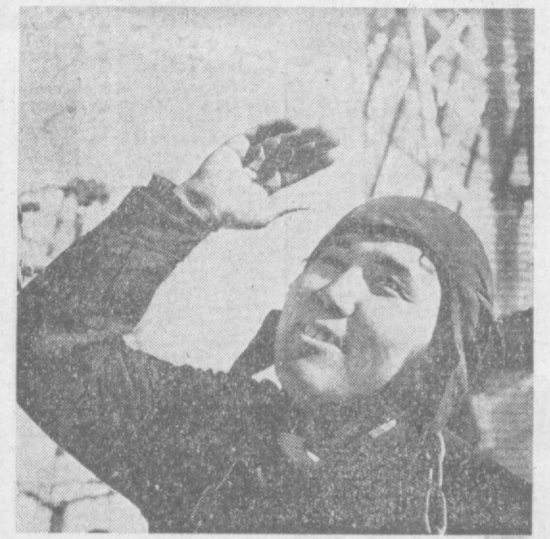
Строители Сырдарьинской ГРЭС приступили к монтажу пятого энергоблока и добиваются высокой производительности труда. Там, на монтаже воздушных выключателей открытого распределительного устройства напряжением 500 киловольт бригады П. В. Петрова за 40 дней смонтировали три линии, тогда как по нормам должна была собрать одну. На этих работах отличился званиевой Жумабек Желдысов. Старший машинист энергоблока Владимир Винторович Эдомский пускал и первый, и четвертый блоки. Волновался одинаково. Теперь он и его товарищи по работе думают о том, как быстрее смонтировать пятый блок. На снимках: старший машинист блока В. В. Эдомский; открытое распределительное устройство; званиевой Ж. Желдысов. Фото Л. Козаленко и Н. Третьякова.
