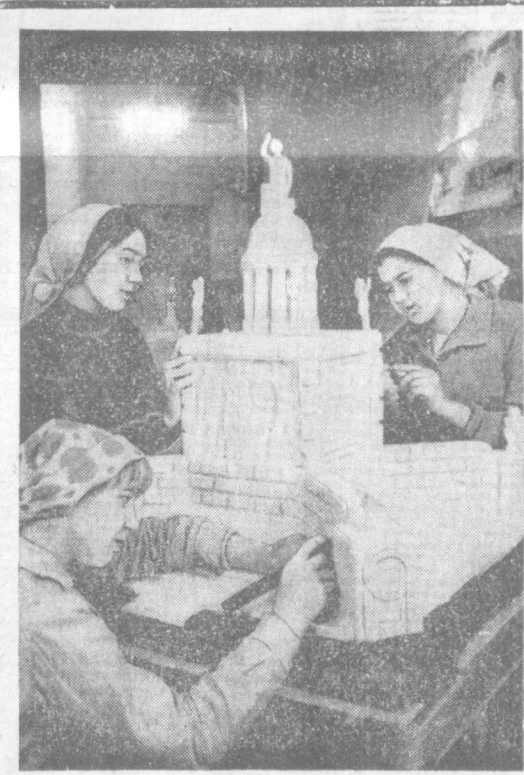
Около 900 будущих строителей обучаются в Самаркандском профессионально-техническом училище № 8. Юноши и девушки получают здесь специальность стюардов, каменищников, монтажников, сантехников, штукатуров. На снимке — будущие маляры Ислам Зарина, Энесора Бадалова и Ольга Ибрагимова создают скульптурную группу, которую они назвали «Свобода».
