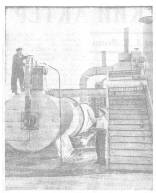
В колхозе «Икзил Узбекистан» Ордонниязтевского района завершается монтаж электротехнической барабанной сушилки, производящей полторы тонны травяной гранулированной муки в час.
