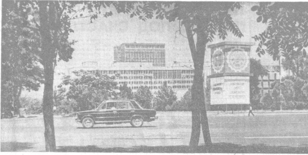
Тот из гостей нашего города, кто периодически его посещает, не может не раздаться стремительному росту строительства в столице Узбекистана. Десятки юбилейных объектов строятся в виде и находятся в стадии завершения. Большие работы ведутся на площади имени В. И. Ленина. К юбилейным торжествам она предстанет в совершенно новом виде. На этом снимке — один из уголков Ташкента. Фото Ш. ИБРАЙМОВА. (УзТА).
