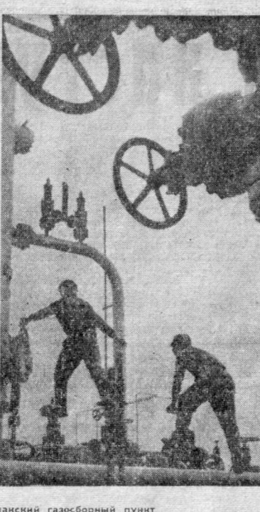
Ачакский газосборный пункт.
