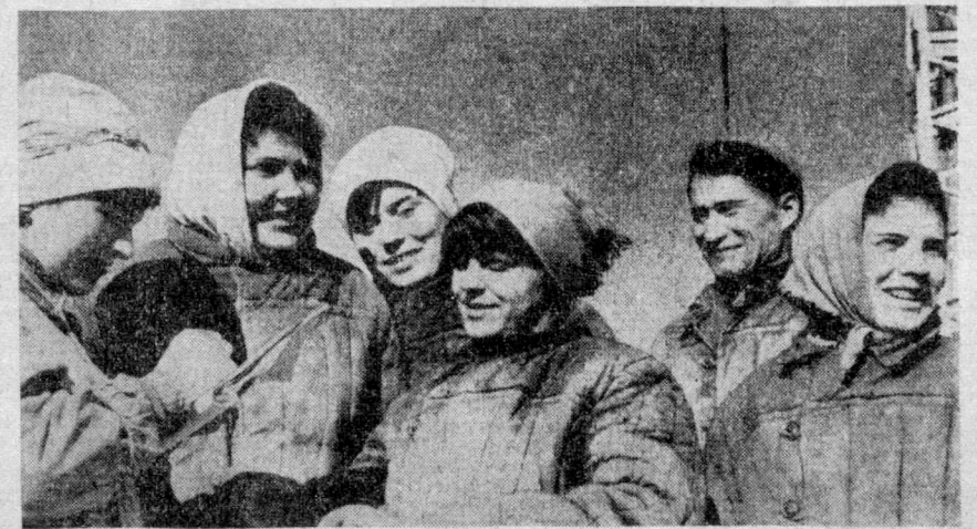
Весом вклад в строительство нового Ташкента посланцев города Ленина. Коллектив Главленгидрострой — сдал жителям нашей столицы четыре стоквартирных дома. Сейчас ленинградцы заканчивают возведение пятого дома. С благодарностью вспоминают жители этих домов и бригаду штукатуров, качество работ которой только отличалось. Члены бригады вы видите на нашем снимке (слева направо): П. И. Трусов, В. В. Елисеев, Т. И. Староников, В. И. Виноградов, А. А. Виноградов и А. В. Мещанов.
