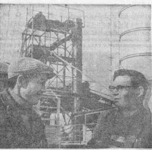
Завершается строительство головного сооружения канала Занг. Новый гидроузел позволит оросить свыше тридцати тысяч гектаров новых земель в Термезском, Джиркунганском и Шерабадском районах. На снимке: бригады бетонщиков Д. Кудратова (слева) и старший прораб З. Наркунова — один из лучших строителей канала. Фото X. Исраилова. (УзТАГ).
