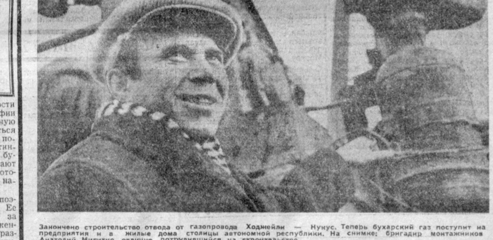
Замечено строительство отвода от газопровода Ходнейли — Нукус. Теперь бухарский газ поступит на предприятия и в жилые дома столицы автономной республики. На снимке: бригадир монтажников Анатолий Мигитко, отлично потрудившийся на строительстве. Фото А. ХОДАКОВА.
