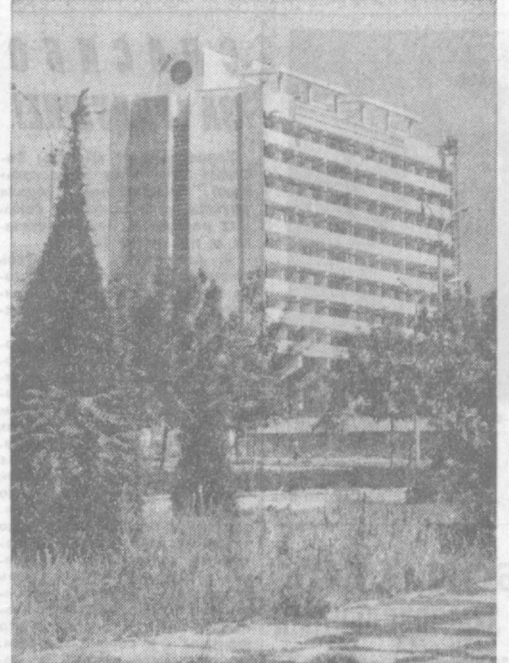
Столицу Узбекистана украсило новое здание: рядом со стадионом «Пахтакор» поднимается этажи Дома молодежи. Фото В. МАЗУРА. (УзТАГ).
