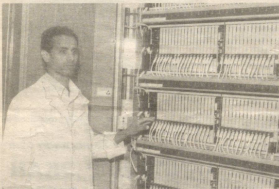
Алоқа соҳасида узоқ йиллардан бери самарали меҳнат қилиб келаётган Шерали ЮСУПОВ Хорватияда малака ошириб келгач, Термиз шаҳарлараро автомат телефон станциясида «Эриксон-Никола-Тесла» компаниясининг АХЕ-10 ускуналарини ўрнатишида фаол қатнашди. Ҳозир у шу корхонада муҳандис бўлиб ишламоқда.
