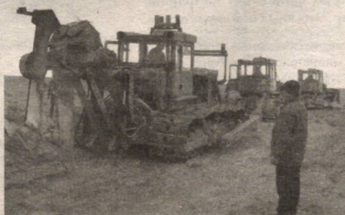
«Қўнғирот — Бейнов» йўналишида оптик толали алоқа линиясини қуриш жараёни. (Фотоархив).
