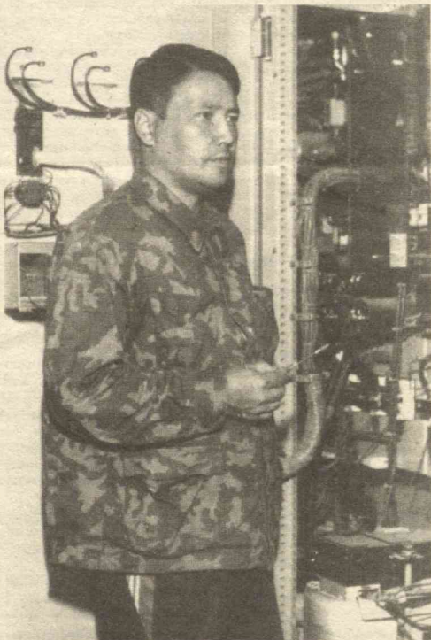
Тошкентдаги 56-АТС электромонтери Иброҳим СОЛИХОВ электр ускуналарни кўздан кечирмоқда.
