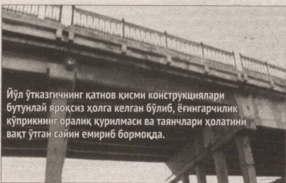
Юк кўтариш қобилияти 80 тоннага мўлжалланган кўприкдан бугунги кунда 100 тоннадан ортиқ оғирликдаги юк машиналари ҳам ҳаракатланмоқда.
