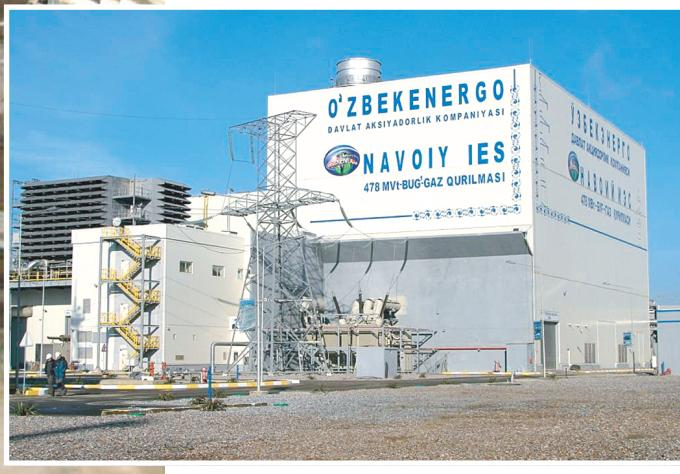
Наглядным свидетельством тому стал ввод в эксплуатацию парогазовой установки на Навоийской ТЭС мощностью 478 мВт производства японской компании «Mitsubishi». Реализация этого проекта, который финансировался полностью за счет государства, позволяет обеспечить дополнительное производство 2,8 миллиарда кВт·ч электроэнергии в год,
