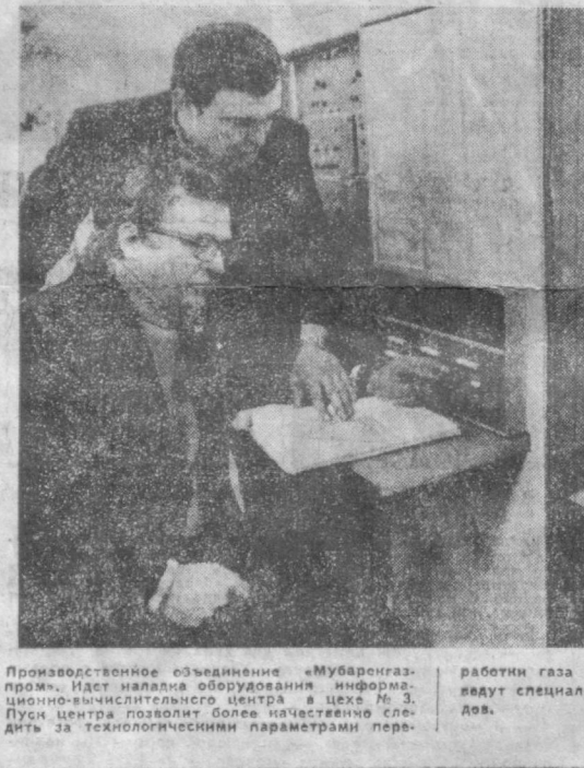
Предметное объединение «Мубаргазпром» ведет монтаж оборудования в цехе № 3. Пуск центра позволит более качественно следить за технологическими параметрами...
