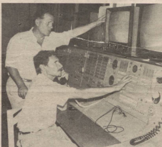
Тошкентдаги Марказий радиорелели станция цех бошлиғи уринбори А. С. ПОЛОТЕВНОВ ва смена бошлиғи В. Н. ХУДОВ ускуналарнинг ишлашини назорат қилишмоқда.
