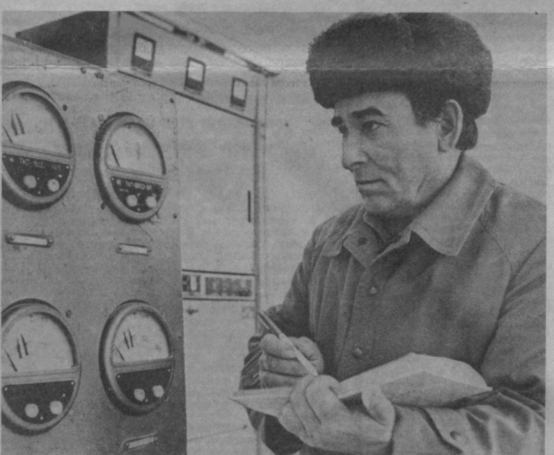
На берегу Амударьи возведено новое гидротехническое сооружение — насосная станция «Искра». Семь мощных насосов поднимают воду почти на 30-метровую высоту, пропускают в секунду до 90 кубометров влаги. «Искра» поможет оросить свыше 40 тысяч гектаров хлопковых и рисовых полей в Гагаринском и Шерабадском районах.
