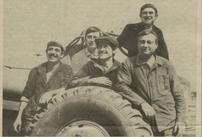
Каршинский опытный ремонтно-механический завод — предприятие многопрофильное. Здесь ремонтируются и изготавливаются крупные металлоконструкции — фермы водопольных башни и другие. По основным направлениям — ремонт дорожной техники, которая поступает из многих городов. Кроме того, предприятие выпускает товары народного потребления. На снимке: один из передовых коллективов — бригада слесарей сиреперного участка (слева направо): электросварщик Э. Трунина, слесарь Ш. Ахмедов, газосварщик М. Падискин, слесарь С. Азизов, бригадир А. Коровин. Фото А. НЕДАВНЕГО.
