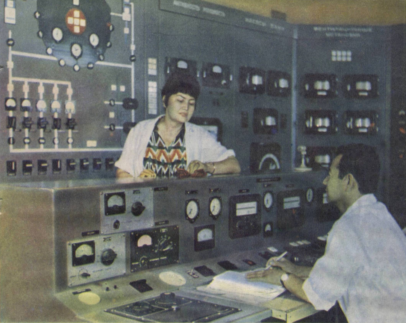
Бош инженер М. Мирзаев ва оператор инженер Д. Отажонова ўртоқлар Ядро институти реакторининг бошқариш пулти ишнин кузатмокдалар.
