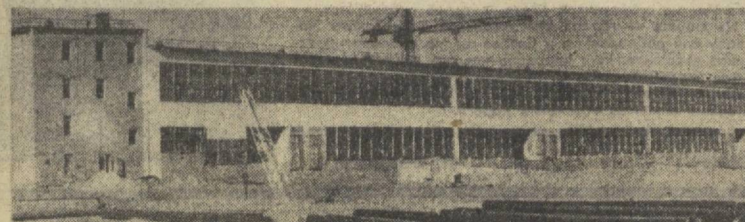
Строительство новых корпусов Узбекского комбината тугоплавких и жаропрочных металлов.
