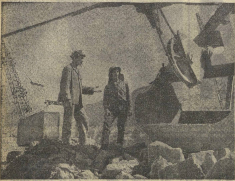
Строители Чарвакской гидроэлектростанции возводят каменно-набросную плотину, верхний гребень которой поднимается на высоту 167 метров. Мощность станции, построенной в отрогах Тянь-Шаня, составит 600 тысяч киловатт. Но главная задача строящегося гидроузла — обеспечить стабильным водоснабжением земли Ташкентского оазиса. Создание Чарвакского водохранилища объемом в два миллиарда кубометров воды позволит орошать дополнительно 140 тысяч гектаров новых земель. На снимке: руководитель бригады скалолазных работ Мамаразим Ширханов и скалолаз Георгий Кайяшун.
