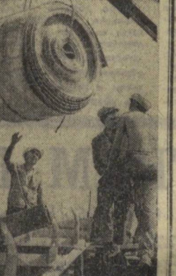
На Ташкентском Домостроительном комбинате, мощность которого превысила полмиллиона квадратных метров жилья в год, заканчивается монтаж леточного транспортера для подачи материалов в бетоносмесительный узел. Фото И. ДУШКИНА. (УЗТАП).
