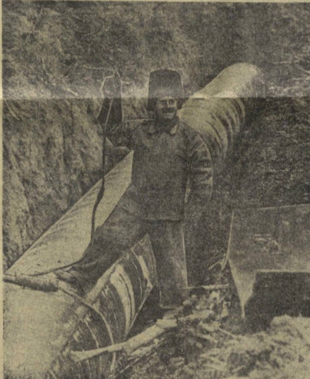
Последний стын на трассе газопровода Средняя Азия — Центр только что свернул Алексей Савин, навалер двух орденов Трудового Красного Знамени. Это произошло под Москвой, у города Воскресенска, в нескольких километрах от Вольского Московского колхоза, которым газопровод охватывает столицу. Ближайший пункт крупнейшей магистрали, которая подает дешовое топливо из Туркмении и Узбекистана в Российскую Федерацию.
