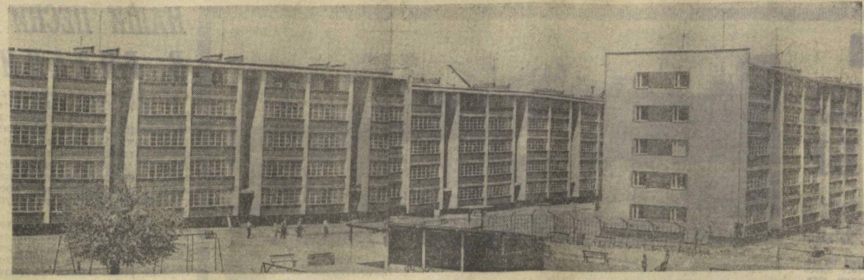
Успешно трудится на строительстве нового Ташкентского общестроительного поезда треста «Риганстрой»...
