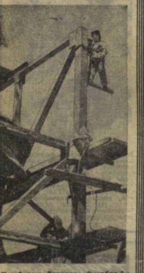
К юбилею Великого Октября будут даны в эксплуатацию шестой в сельской энергосети Наркентской ГЭС. На снимке: передвижные электростанции Ю. Соловьев, В. Тюляев и Н. Юнича на монтаже 7-го блока.
