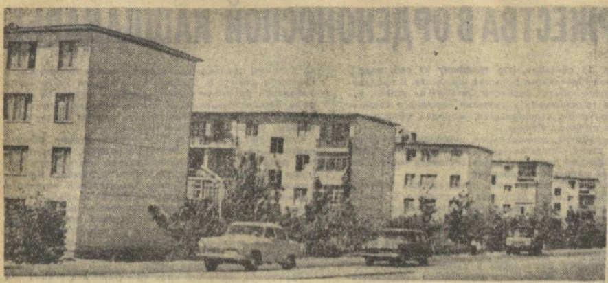
Городок строителей и эксплуатационников Ташкентской ГРЭС.
