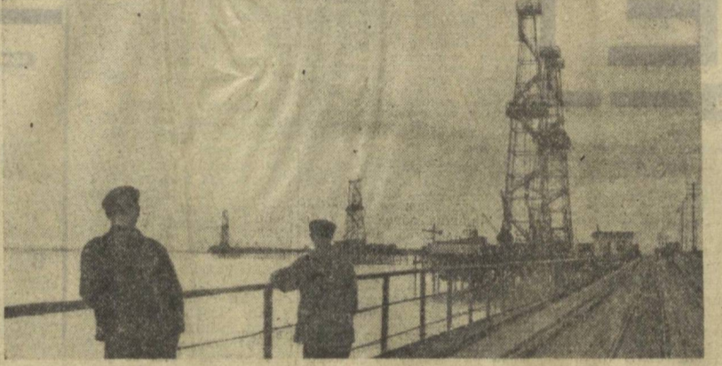
Строители Туркмении собирают в восточной части Каспийского моря нефтяные промыслы. Построен третий металлургический остров в 23 километрах от полуострова Челекен. От полуострова в море уходит полутораклометровый металлическая эстакада с 18-ю сваями, которые дают нефть. На снимке: Челекенская эстакада.
