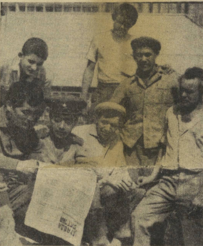
Одно из первых мест в предоктябрьском социалистическом соревновании в коллективе строительного управления № 2 треста «Высотстрой» занимает бригада Г. В. Гулевского. На строительстве здания Совета Министров Узбекской ССР в Ташкенте она ежедневно перевыполняет нормы выработки.
