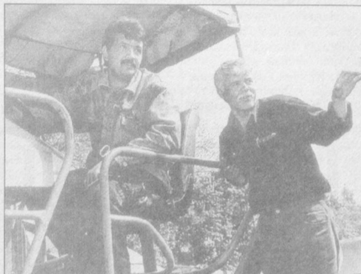
Курйилиш майдонида Жану-тайёргарлик ишлари бажарилди. Яна бир ой ўтгач ушбу замонвий ва раvon йўлдан икки томонлама транспорт қатнови йўлга қўйилади. Йўлни таллаб-келтирилган юксак унумли техникалар жалб этилган. Шу кунга қадар трамвай рельслари олиб ташланиб, текислаш ҳамда йўлни кенгайтириш учун
