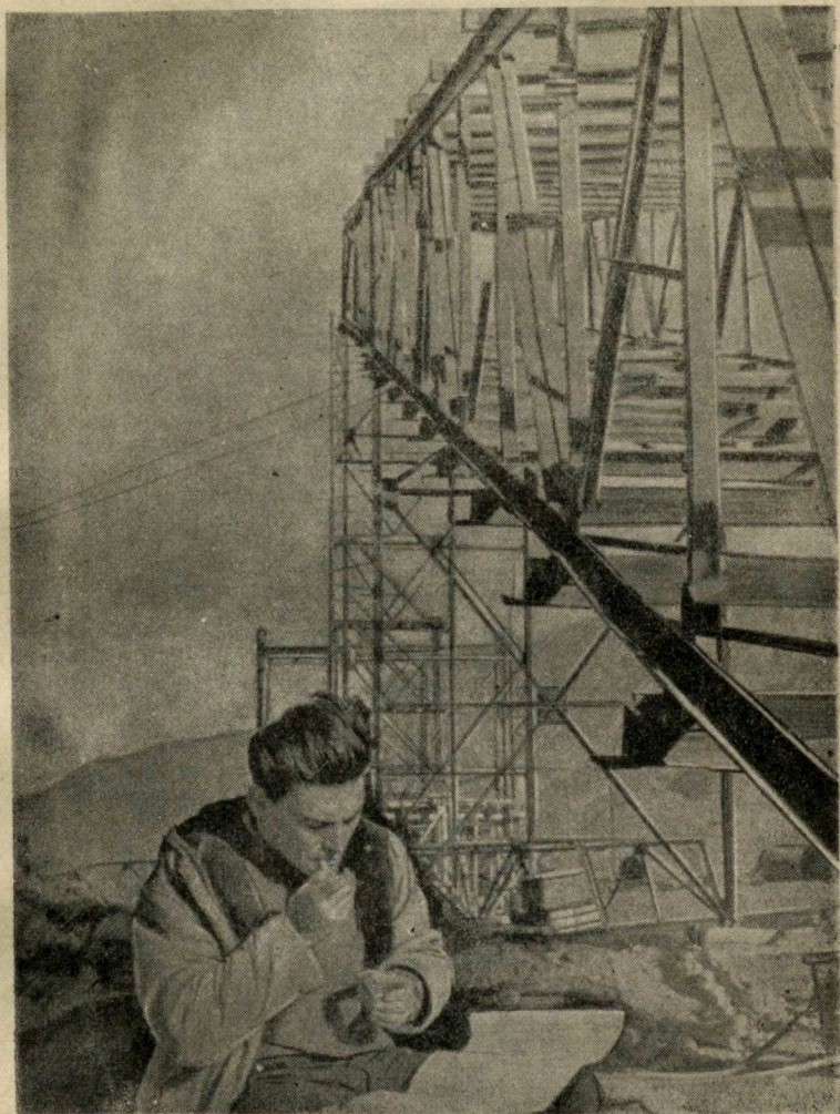
Молодой инженер-комсомолец Юрий Артёмов у козлового крана в районе строительства бетонного завода.
