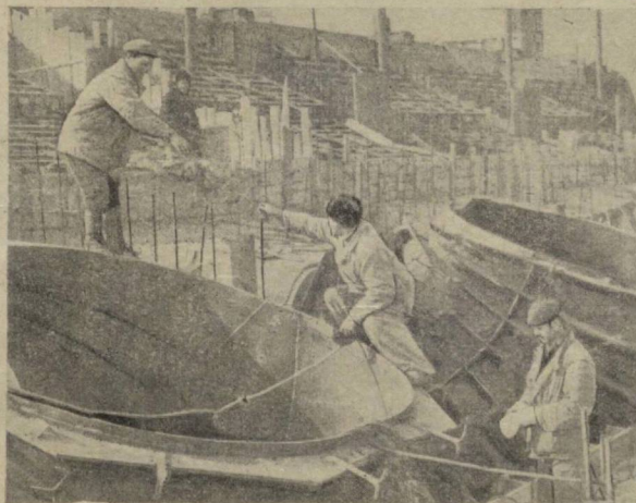
Канал трассасида азамат трубопроводлар монтаж қилинмоқда.
