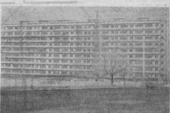
Бу бино Чилонзор районидagi «Ташсовет» 50-йиллиги номи ки-нотеатр билан ёна-ён қад қўтарди. Уни 6-трест, 27-қурилиш бош-қармасининг бинюкларни қурмоқдалар. Бу тўққиз қаватли уйга кў-чиб кирувчилар учун бинюклар барча қулайликларини яратмоқ-далар. Л. Глауберзон фотолари.
