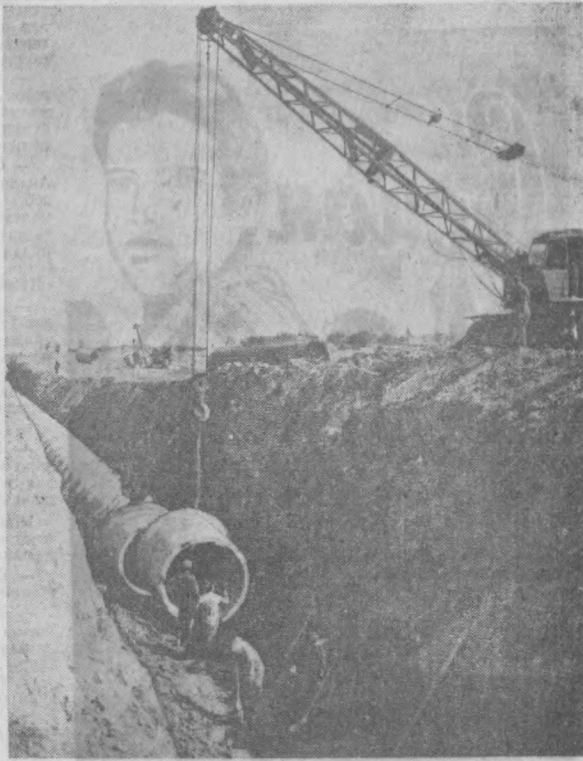
Қорақамиш коллектори ўрнатилмоқда. Я. Каминер фотоси.
