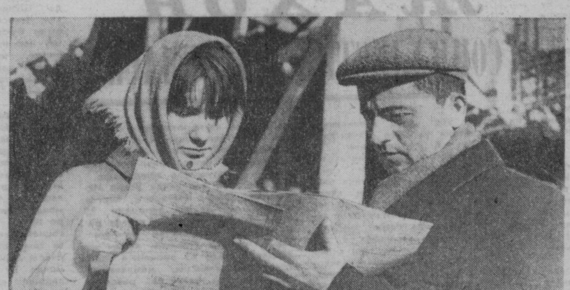
Ленинград кўчасида янги маъмурий бино қад кўтаряпти. Уни «Вистотстрой»га қарашли 11-трестнинг 49-қурилиш бошқармаси буюмлари бунёд этишяпти.
