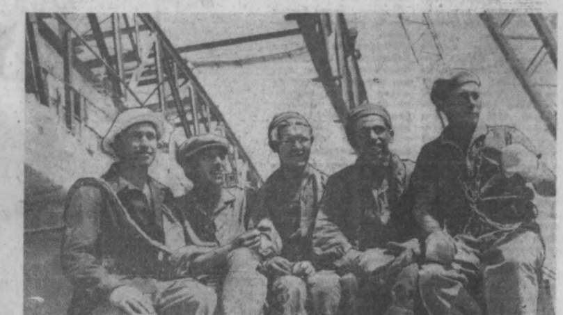
Махсус пўлат монтаж трестининг Гантель Муслимов бошчилик қилаётган бригада монтажчилари ой сайин ишлаб чиқариш планини ортиги билан бажармоқдалар. Ҳозир улар яхмалак майдони қурилишда зўр бериб меҳнат қилмоқдалар. СУРАТДА: (чандан) В. Якубаев, В. Турфанов, В. Чекуров, У. Аҳонгаров, бригада бошлиғи Б. Муслимов ўртоқлар. М. Миржалилов фотоси.
