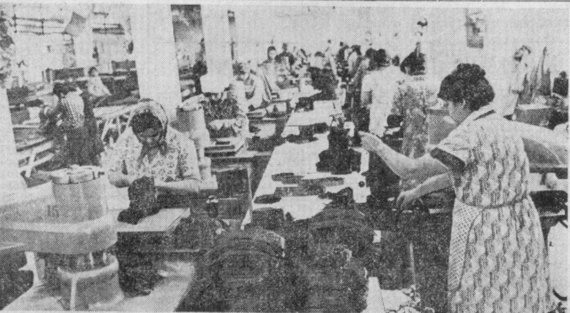
Тошкент кўн-галатерия ва спорт буюмлари ишлаб чиқариш бирлашмаси цехлари замонавий техника ва технология билан жиҳозланган. Ушбу суратда механизациялаштирилган бичиш конвейери тасвирланган. Бу ерда мураккаб бичиш ишларининг ҳаммаси механизмлар ёрдамида бажарилади.
