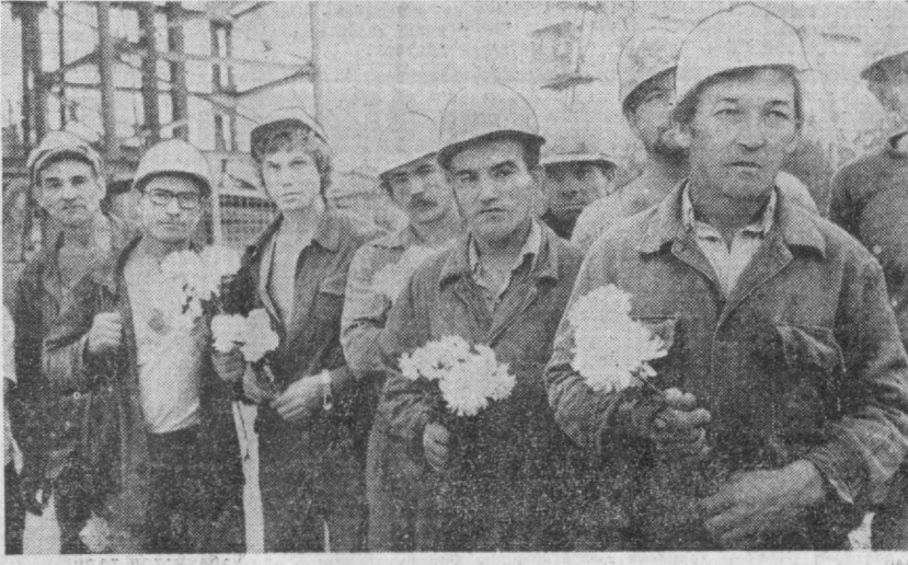
Улуғ Октябр байрами арафасида 11-шаҳтанинг 4-участисини бунёдкорлари «Космонавтар» илҳомбахш меҳнатини амалга ошириб, шахта билан станция қуриладиган оралиқда — прохонда ишларини яқинлашди. Метросозлар бу иш бошини тугаллаганини мунсабат билан уларга гуллар тўшириди.
