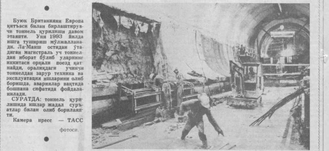
Буюк Британия Европа қитъаси билан бирлаштирувчи тоннель қурилиши давом этапти. Уни 1993 йилда ишга тушириш мўлжалланади. Ла-Манш остидаги ундаган магистраль уч тоннелдан иборат бўлиб уларнинг икитаси орқали поезд қатнайди, оралиқдаги учинчи тоннелдан зарур техника ва эксплуатация ишларини олиб боришда, авариалар вақтида бошана сифатида фойдаланилади. СУРАТДА: тоннель қурилишида ишлар жадал суръатлар билан олиб борилапти. Камера пресс — ТАСС фотоси.
