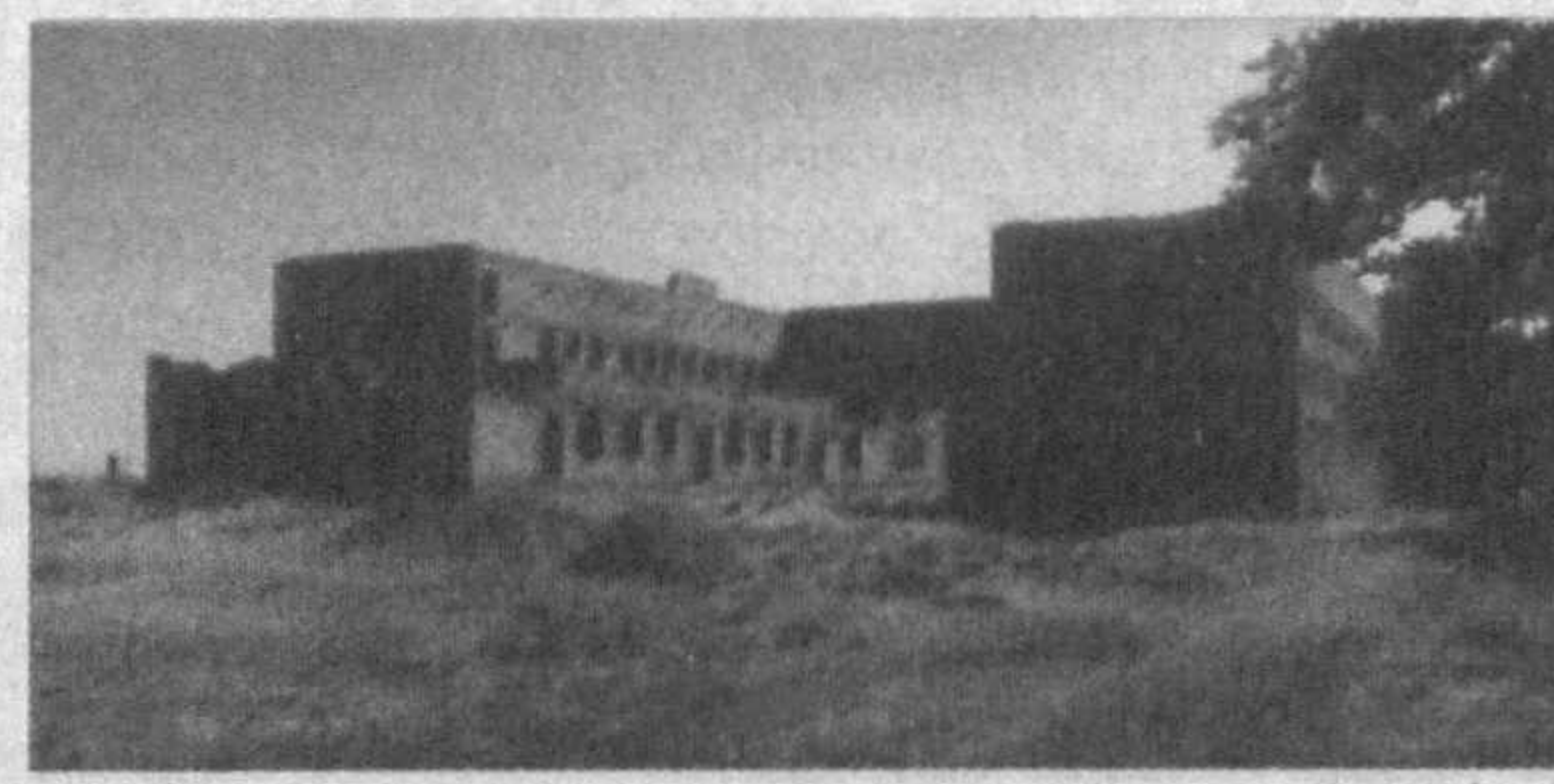
Тошкент шаҳри, Бектемир тумани, Сувчи даҳаси, Чо Мен Хи кўчасида жойлашган қурилиши тугалланмаган поликлиника биноси. Бошланғич баҳоси — 894 275,28 АҚШ доллари.
