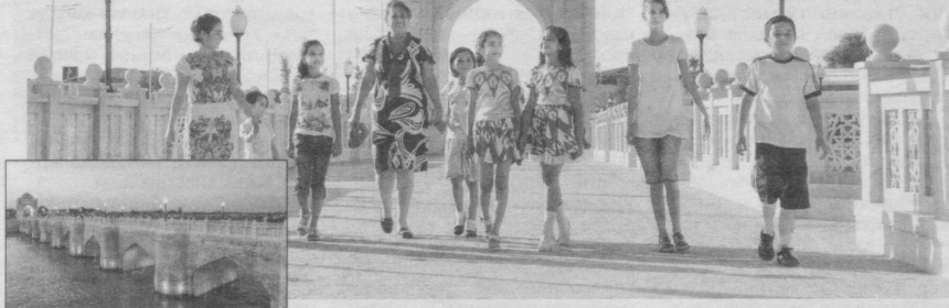
Амир Темур кўприги ва унинг атрофида барпо этилган гўзал хиёбон фойдаланишга топширилди.
