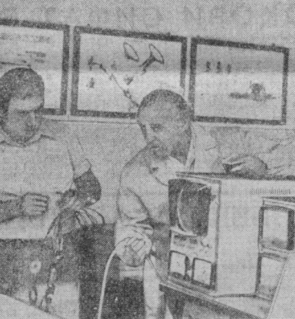
Волга автомобиль заводининг Тошкентдаги автомобиль марказида «Жигули» автомобилларини назорат қилувчи участка ишга тушди. Машиналарнинг техник ҳолатини аниқловчи бу участка энг замонавий асбоб-усуналар билан жиҳозланган. СУРАТДА: автомакиаз мутахассислари оператор Ш. Аниевни, участка бошлиги У. Саидилов ва мастер Е. Велфорлар махсус аппаратлар ёрдамида навабдаги автомобилнинг техник ҳолатини кузатмоқдалар.
