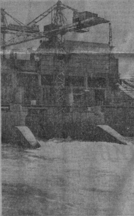
Строители Газалкентской ГЭС приступили к монтажу второго гидроагрегата, который предполагается включить в энергосеть уже в конце августа нынешнего года. Одновременно ведется сооружение здания электростанции. На снимках: строится здание ГЭС; бригадир передовой комплексной бригады
