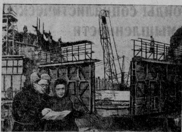
На «Волгодонстрое». Широко развернуты работы по сооружению 10-го шлюза. На снимке: руководитель строительства верхней части шлюза инженер Г. Шенклов получает задание у начальника шлюза П. Липатова. Фото С. Кропивицкого. (Фотохроника ТАСС).
