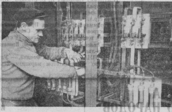
Чирчинский завод «Электрострой» выполняет важные заказы для электростанций. На снимке: монтажники-стахановец Г. Колесников проваивают монтажные работы, выполняя задания на 200—220 процентов.
