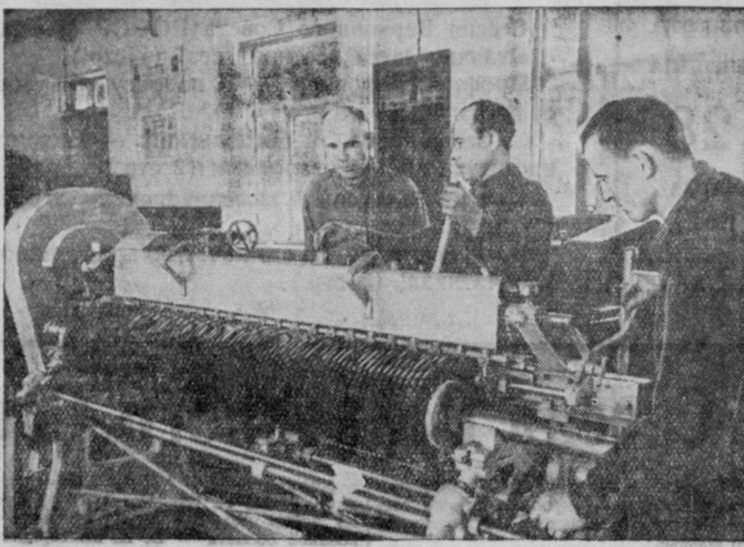
Ташкентский завод «Авторакетордеталь» изготовил автоматы по заточке пил для хлопкоочистительных заводов. На снимке (слева направо): начальник цеха Н. Ф. Наумов, фрезеровщик М. И. Чуристов и слесарь-сборщик А. И. Еременко за проверкой собранной машины.
