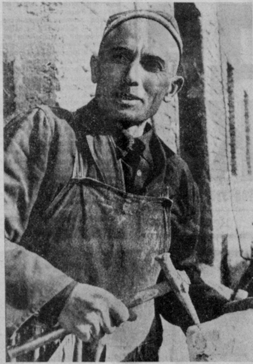
Строительная бригада, возглавляемая коммунистом Джурраббеком Хасановым, возводит 16-квартирный дом в районце Наманганского района. Сейчас Хасанов работает в счет 1983 года. На снимке: Д. Хасанов.
