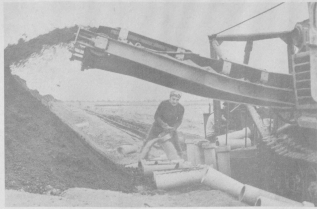
Нарращивают темпы работ меллиораторы дренажно-строительного управления № 5 треста «Дренажстрой» управления «Каршистрой». Основная работа по закладке дренажных труб ведется в совхозах № 51 и № 52 Насанского и Чиракчинского районов. В этом году меллиораторы должны освободить 150.000 рублей, или заложить 400 километров дренажных труб. Ежедневно они укладывают 15-20 километров труб.
