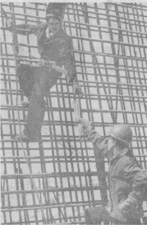
Полным ходом идет строительство насосной станции № 2 — пускового объекта на строительстве магистральной оросительной системы в Диназской степи. На снимке: монтаж арматуры здания станции ведут передовые рабочие Михаил Лазарев (внизу) и Александр Самсонов из ПМК-52 треста «Гидрострой». Фото В. ВАСКАОВА.
